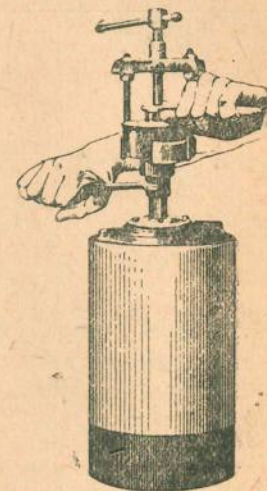
Рис. 31. Разборка фрикционной муфты привода электрогенератора
